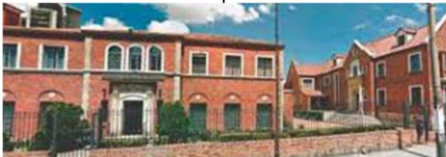
Figs. 1.5 y 1.6.- Fachadas de la sede de la Academia Nacional de Medicina de Colombia (Sede Principal y Biblioteca “Jorge E. Caveller Jiménez”). Carrera 7ª N° 69-11, Bogotá, D. C.
